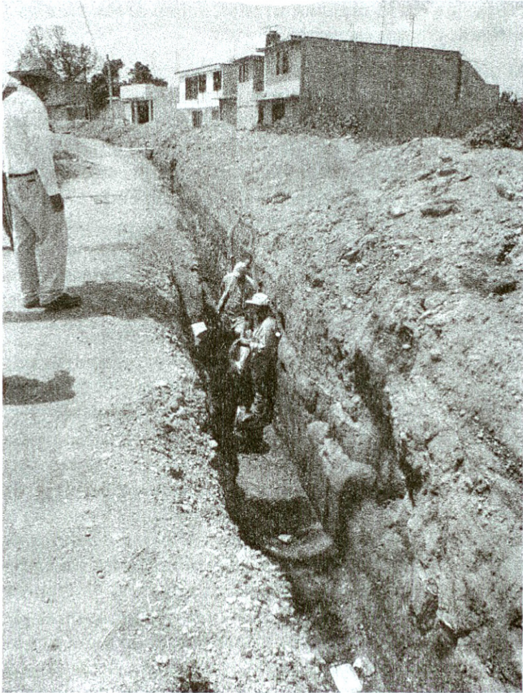
Calle Morelos, zanja para drenaje, Tocuila
